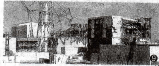
福島第一原発の原子炉建屋。手前から4号機、3号機、2号機、1号機。11年11月12日
